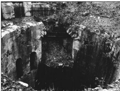
Der mächtige Geschützbrunnen des Küstenforts Verudella für zwei 28 cm-Minimalschartenkanonen in einem Panzerturm der Firma Gruson (Gre)
