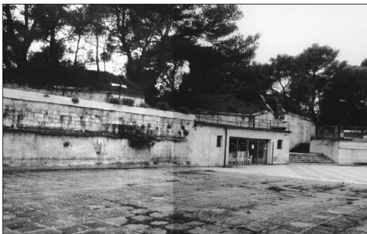
Die ehemalige Wasserauffangfläche der Küstenbatterie Giovanni wird heute als Tanzfläche verwendet (Gre)
