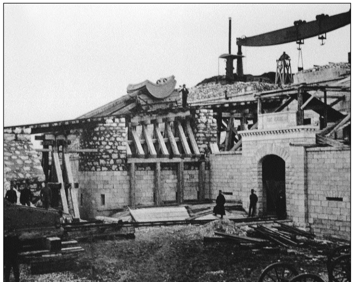
Über dem Kehlkofer des Küstenforts Verudella wurde eine Rampe errichtet, um die Turmpanzerteile transportieren zu können (KA)
